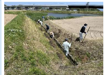
共同活動 (水路の泥上げ)
