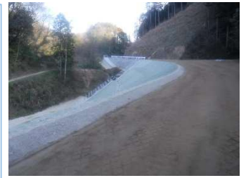
農道整備 (歌仙3期地区)
