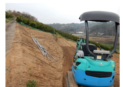
農家自主施工による緩傾斜化
