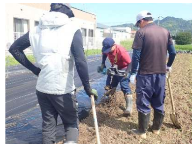
縦穴による排水性改善
