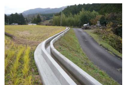
農業用排水路
