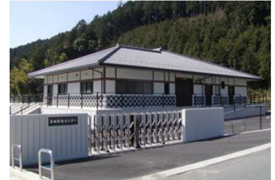
農業集落排水施設
