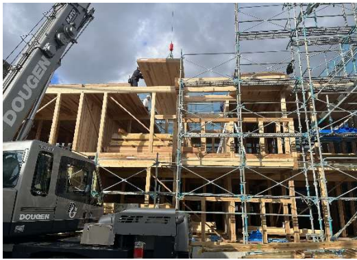
CLT建築物の建設支援（3階建て集合住宅）
