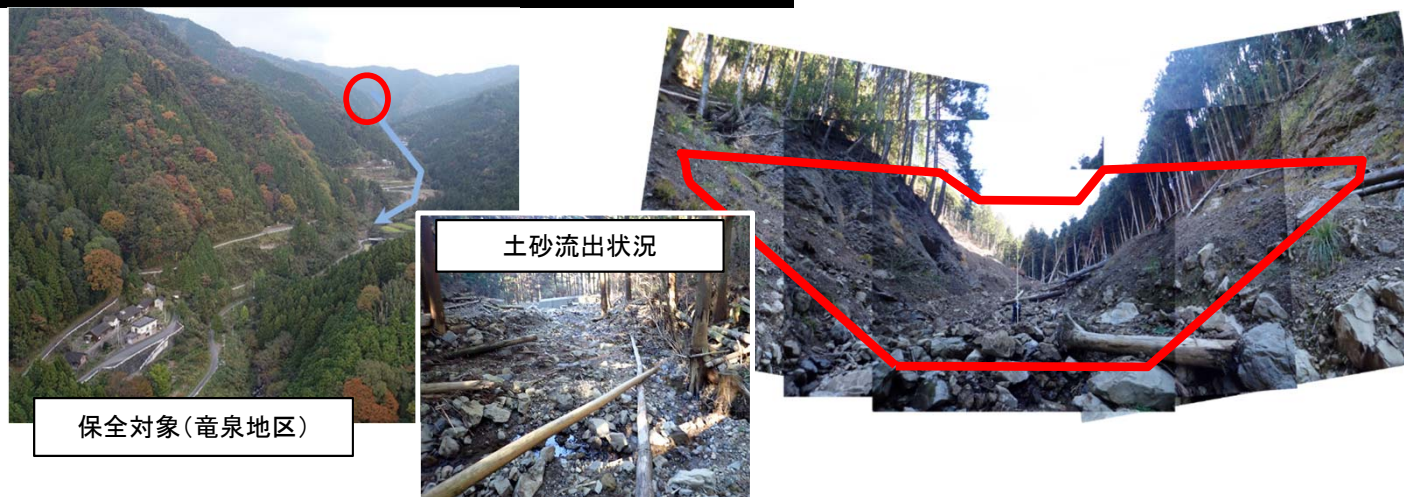
復旧治山事業(西予市城川町野井川)
