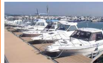
プレジャーボート係留施設 (大浜漁港・今治市)
