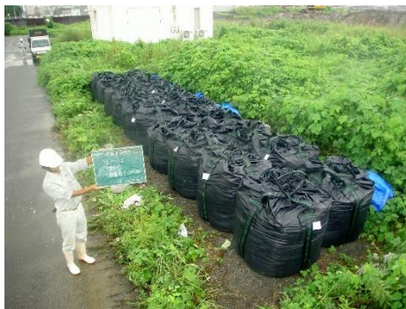
・菊本 大型土嚢設置
