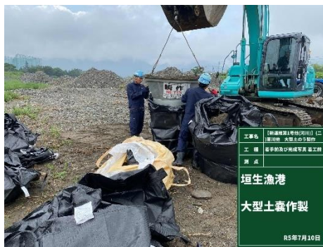
・垣生 大型土嚢作成風景
