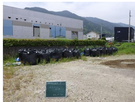
・山根 大型土嚢設置
