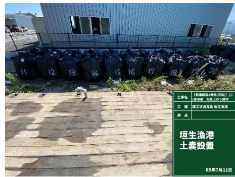
・垣生 大型土嚢設置
