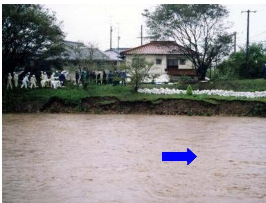
松山市 (二)立岩川 護岸崩壊
