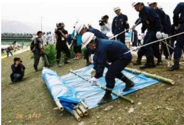
シート張り工
