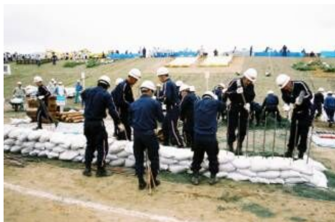
積み土のう工
