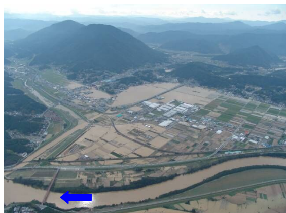
平成16年8月 台風16号 肱川(大洲市)
