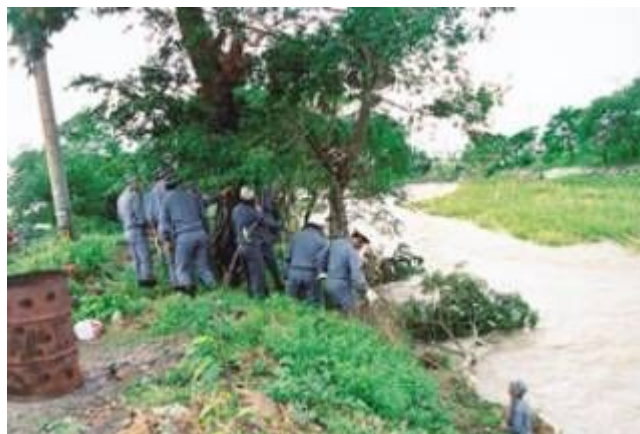
木流し工による水防活動 立岩川(平成3年6月/松山市)
