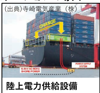
陸上電力供給設備 (出典)寺崎電気産業(株)
