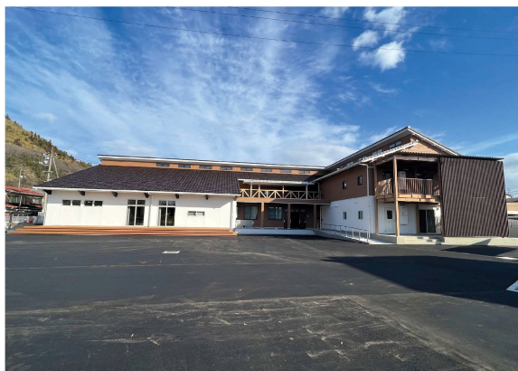
県関連施設整備事業 (弓削高等学校学生寮 (上島町))
