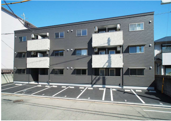
CLT建築物支援事業 (CLTを使用した3階建て集合住宅)
