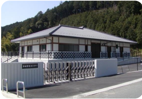
農業集落排水施設の整備（西予市）
