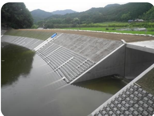
堤体を改修したため池（松野町）
