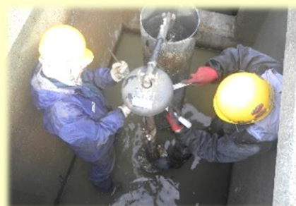
パイプラインのバルブ更新
