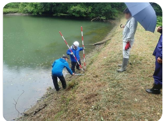
愛媛県ため池保全サポートセンターによるため池点検
