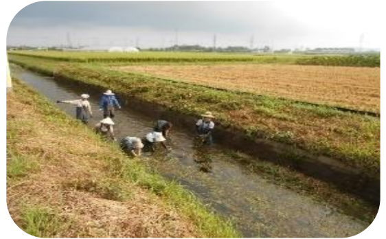
水路の泥上げ（西条市）
