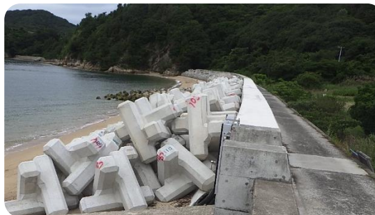
堤防の嵩上げ (上島町：佐島東地区)
