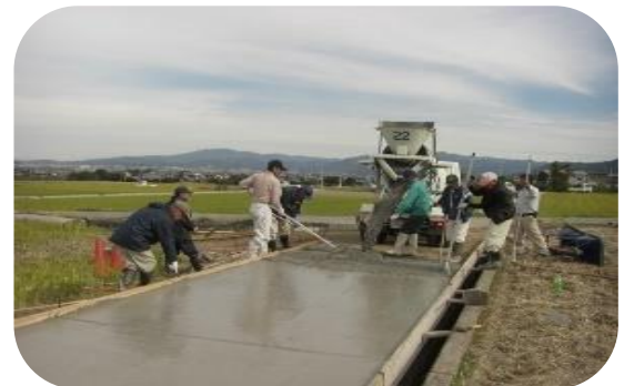
農道の舗装（伊予市）
