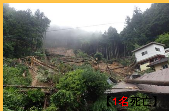
大洲市北裏 土砂崩れ
