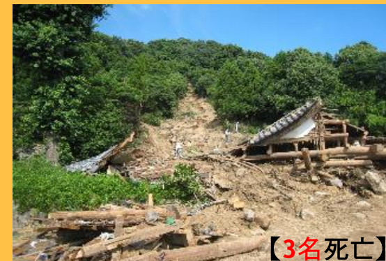
松山市上怒和 土砂崩れ
