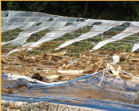
西予市宇和町のブドウハウス被害
