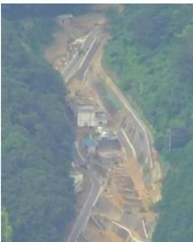
豪雨により土砂災害が発生 主要な浄水場が被災
