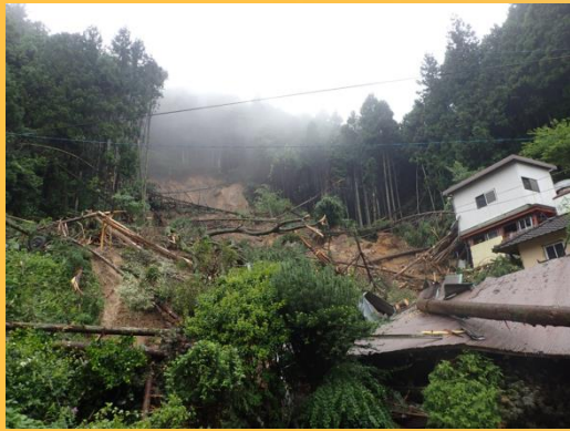
大洲市北裏の林地被害
