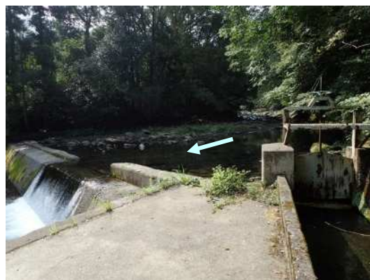
関井堰（大川頭首工）
