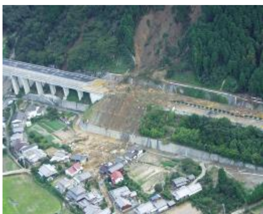
H16 台風第21号 がけ崩れ（新居浜市）
