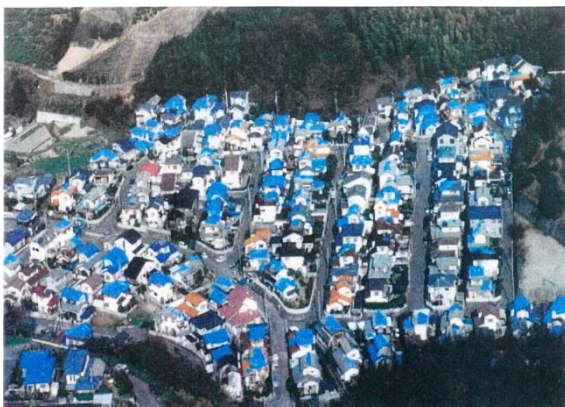
H13 芸予地震 屋根が損壊し、ブルーシートで応急処置した住宅 (松山市)
