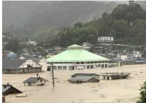
H30 西日本豪雨 肱川氾濫（西予市）
