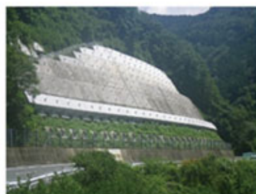
法面防災対策(アンカー工)
