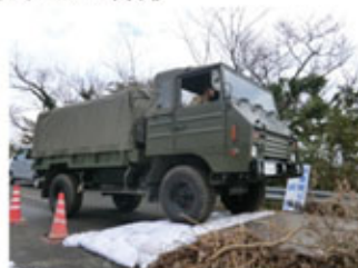
段差すりつけ (土のう使用)
