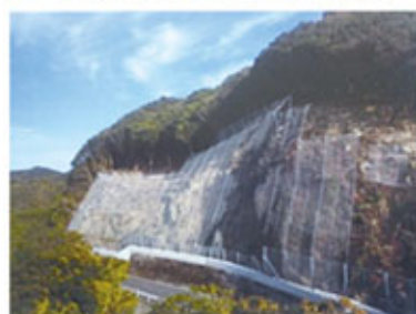
法面防災対策(落石防護工)
