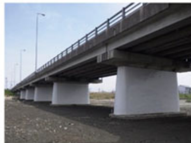
橋梁耐震対策(橋脚巻立工)
