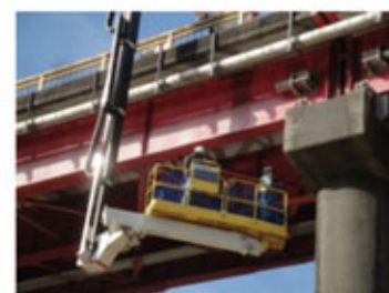
【橋梁点検車による定期点検】
