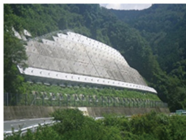
法面防災対策(アンカー工)
