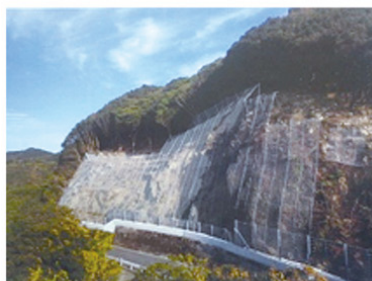
法面防災対策(落石防護工)
