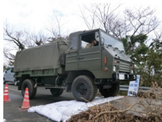
段差すりつけ (土のう使用)
