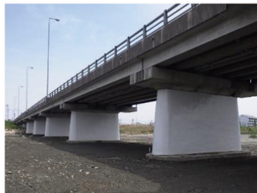
橋梁耐震対策(橋脚巻立工)
