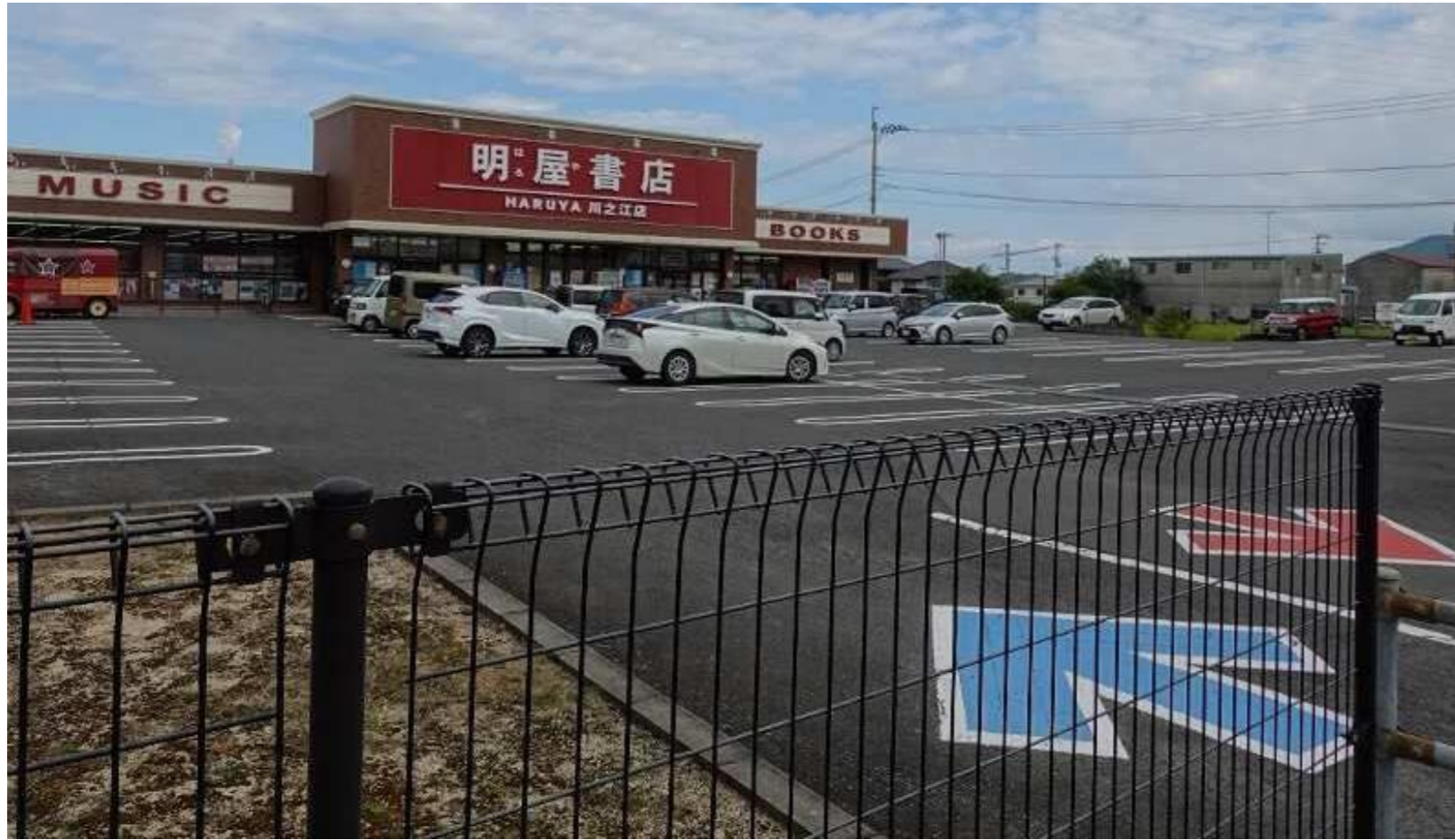
【既存店舗（明屋書店棟） 外観】
