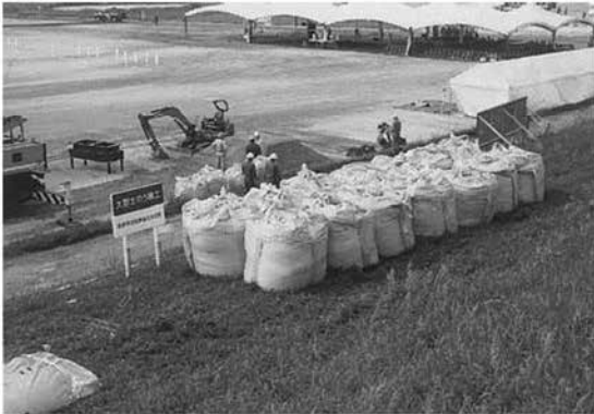
(大型土のう工)
