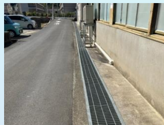
↑側溝の整備工事の写真
