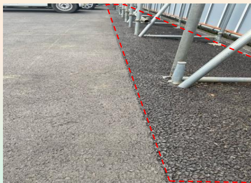
↑透水性舗装の敷設の写真
