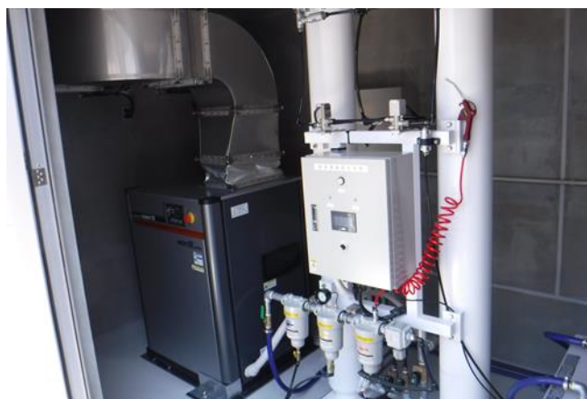
写真2 上段：90トン水産 中段：75トン水槽 下段：酸素発生装置
