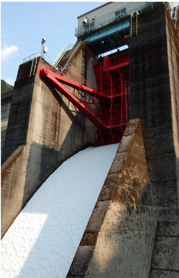
●クレストゲート 洪水時の洪水調節に使用するゲートで、ダムに流れ込む多量の水を放流することができます。
