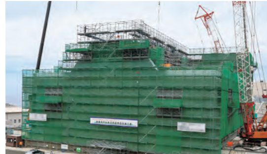
建物の基礎部分や壁面を構築する工事を実施中 (2023年7月現在)
