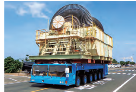
2号機のタービンを取り外して搬出する様子
