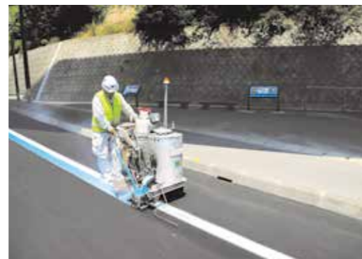
媛マルライン施工
