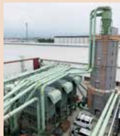
▲配管と集塵機据付工事
