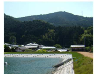
ため池の改修
