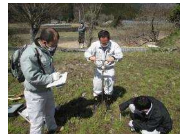
ナベラ地区の土質調査状況
