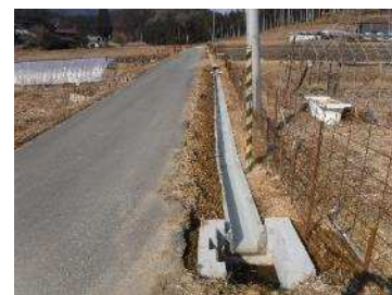
槇の川地区の水路整備状況
