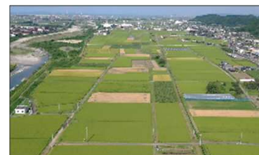
県営事業で整備された農地
