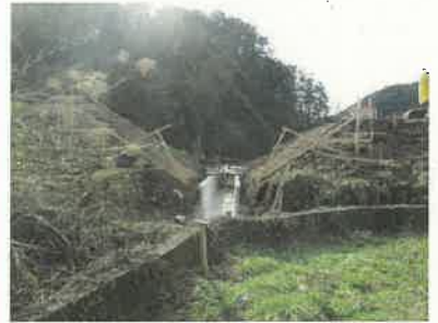
ため池の廃止（施行中）
