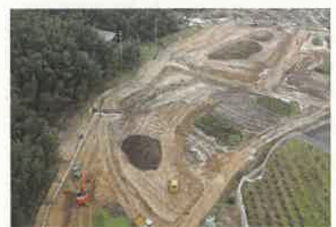
ほ場整備施工状況
