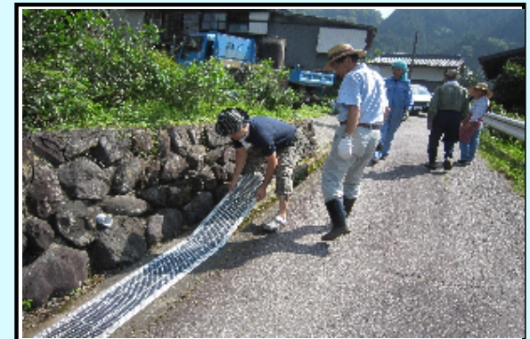
村道の側溝蓋の取り換え・設置
