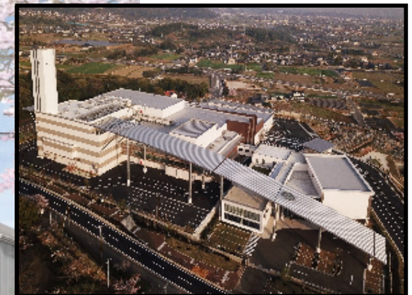
完成したバリクリーン(ドローン撮影)
