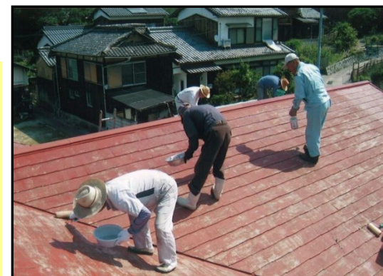
集会所の屋根の改修
