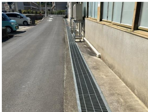
↑側溝の整備工事・清掃・グレーチング化工事
