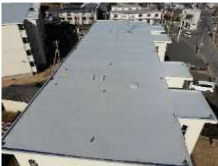
▲市営住宅の屋根部分撮影
