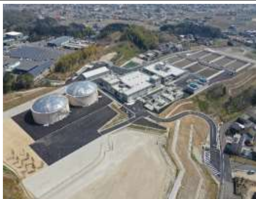
浄水場施設全景
